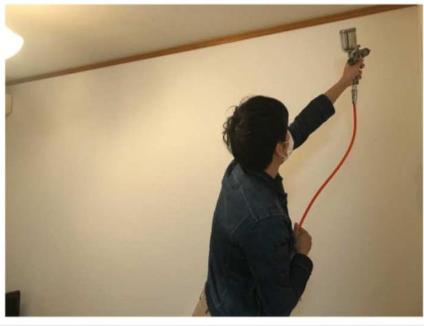
コーティング剤を物質の表面にエアースプレーガンで吹き付け乾燥させます。すると、目には見えないごく薄い膜（1ミクロン程）ができます。
